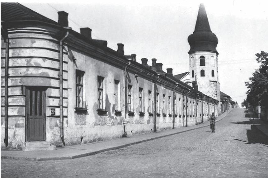
Keisarinkatu 15. Näissä korttelin ympäri kiertävissä matalissa, pitkulaisissa, rakennuksissa Viipurin poliisilaitoksella oli monenlaista toimintaa. Kulmaovesta oli kulku keskuspoliisiasemalle. – Kuva: Wiipuri-Yhdistys ry. WAY. E3a10. (CC BY 4.0).
